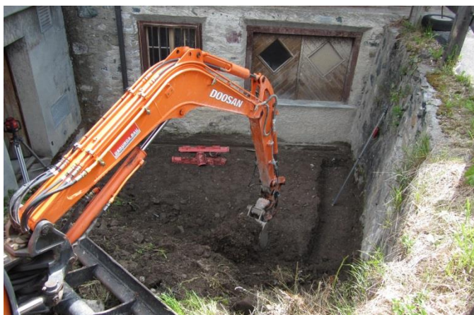
Aushub für den Skiraum und das Treppenhaus
